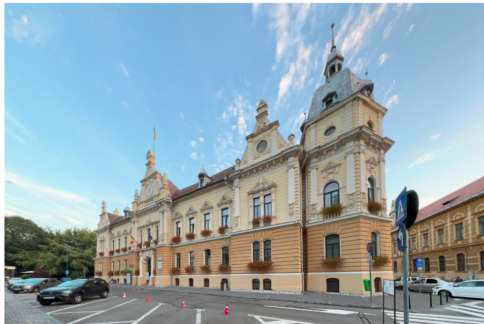
Primăria Brașov - existent ziua
